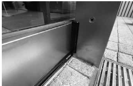
図10 薄型のブラシを自動ドアの外側に取り付け、虫がドアのレールに落ちて内部に侵入するのを防いだ例
