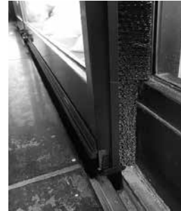
図9 密着するよう壁側の隙間に合わせて毛を刈ったブラシの施工例
