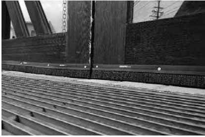
図6 木製ドア下部のビス止め施工例
