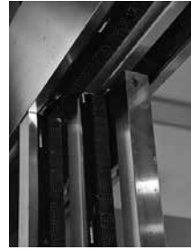
図7 自動ドアの縦方向の隙間対策例
