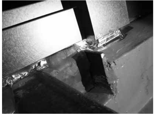
写真2 展示室の隙間を埋める処置
