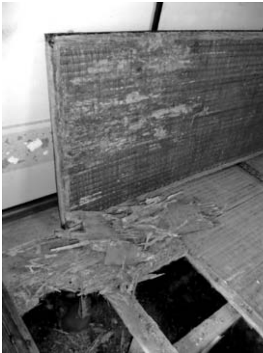
写真11 写真10の畳を上げると、ヤマトシロアリにひどく食害されていた床板と畳(裏面)
