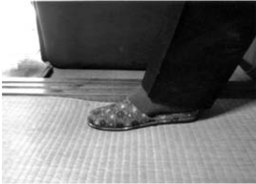
写真10 足で強く踏み込むと、シロアリ被害のためへこむ畳
