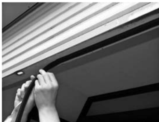
図3 入口シャッターに隙間テープを設置
