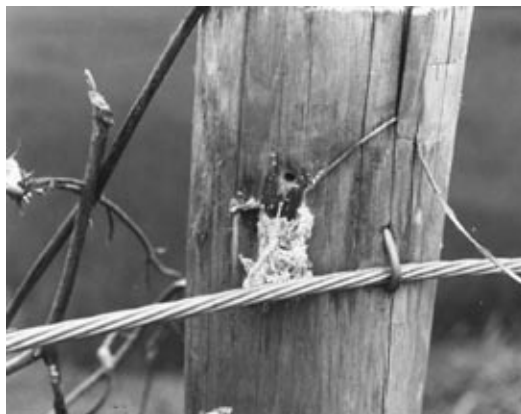
写真10 コウモリガの幼虫に穿孔食害された木柱 (写真中央)
